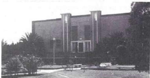
Planta de bombeo y cloronización de agua potable de Xotepingo.
